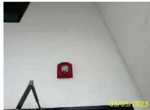
อุปกรณ์ส่งเสียงและเสียงสัญญาณแจ้งเหตุ
