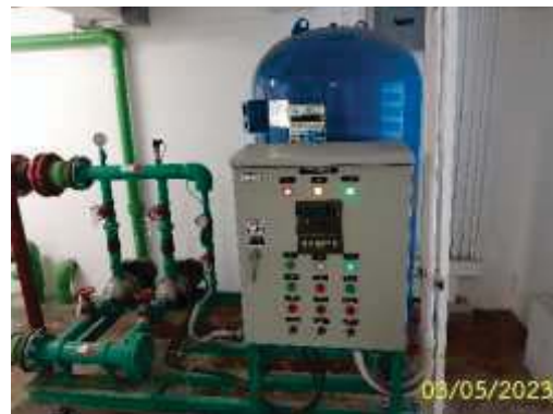
ระบบสูบน้ำชั้นดาดฟ้า
