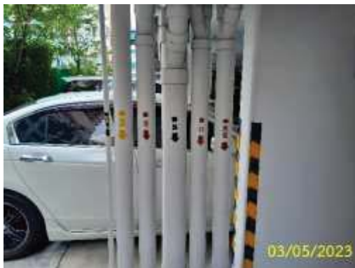
ท่อรวบรวมน้ำฝนและท่อรวบรวมน้ำเสีย
