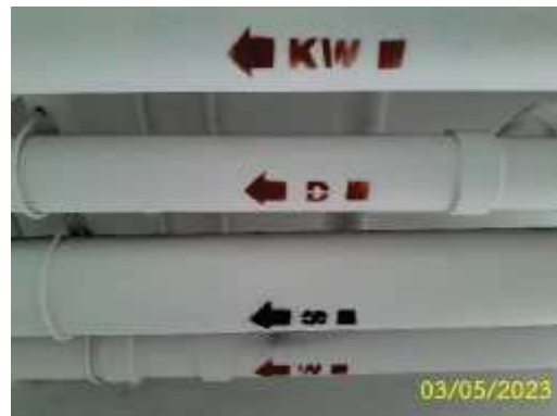
ท่อรวบรวมน้ำฝนและท่อรวบรวมน้ำเสีย
